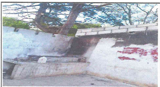
Foto 4: Levantado de muro para colocar estructura de metal
